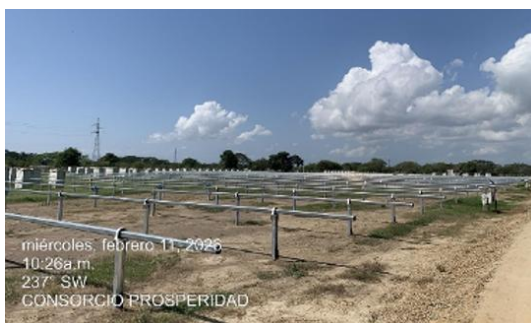
Instalación de trackers
