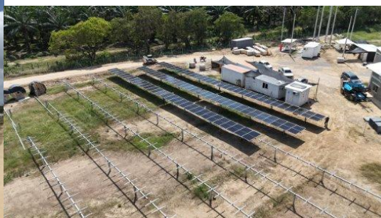
Instalación de paneles
