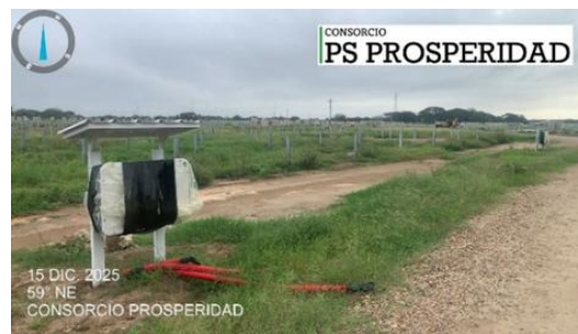
Instalación de inversores
