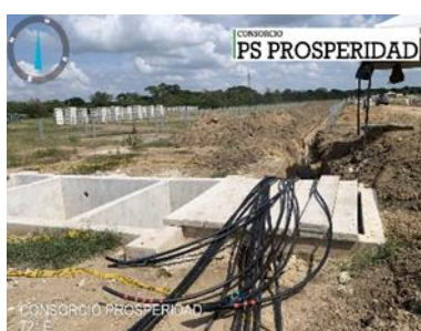
Tendido de cable de baja tensión
