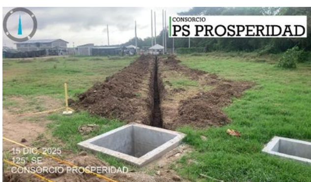
Construcción de línea de interconexión
