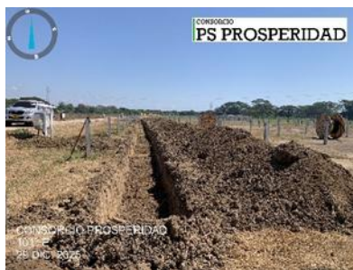
Tendido de cable de baja tensión
