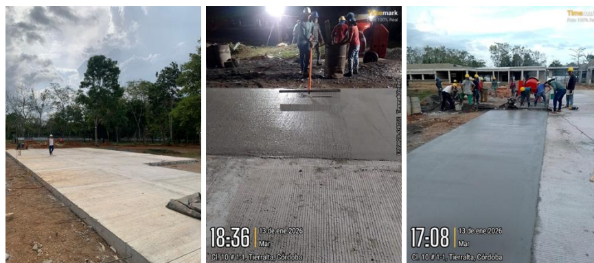
Relleno, compactación y fundida de vía interna
