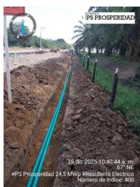
Construcción de línea de interconexión
