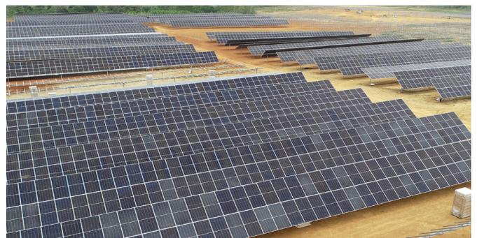
Esta planta utiliza tecnología TRINA Super Track, que corresponde a una tecnología de seguimiento inteligente con trackers o seguidores, los cuales responden a un programa de posicionamiento del sol, ajustando la inclinación de los paneles solares para que siempre estén perpendiculares a la radiación solar directa, optimizando el ángulo de inclinación del tracker, capturando más radiación y aumentando la capacidad de generación de energía hasta en un 12 % en días nublados.
