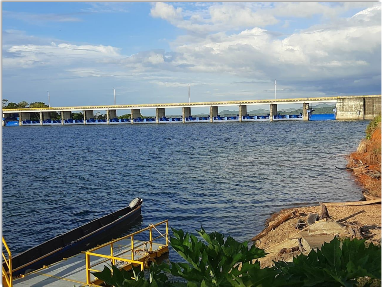
Puente sobre el vertedero – diques fusibles - embalse de la Central Hidroeléctrica URRÁ I
