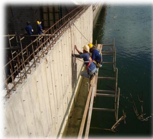
aplicación de sanciones por parte de Regulador. Con base en diseños estructurales contratados por URRÁ, se procedió por parte del Contratista CCE con la construcción de dos muros (uno en cada vano externo) entre elevaciones 125 msnm y 128 msnm, un ancho de
