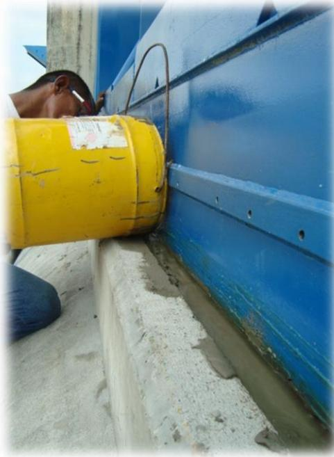
**RELLENO DE LAS CUÑAS DE SELLO CON MORTERO AUTONIVELANTE**
