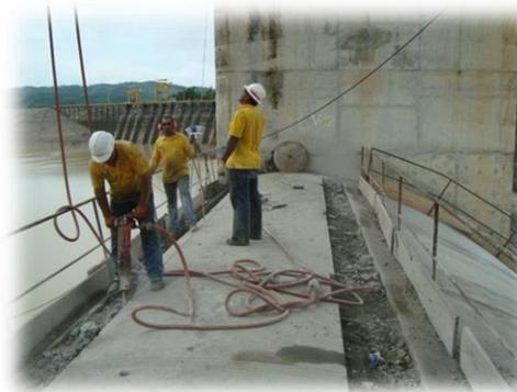
Los escombros, resultado de la demolición no debían ser arrojados al embalse por lo que el Contratista realizó el ascenso de éstos al puente y luego los dispuso en el botadero acondicionado en la época de construcción.
